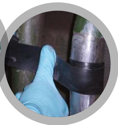
Réparation de fuites d'huile
